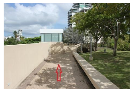
Escalera Emergencia Lado Derecho Plaza Laguna
